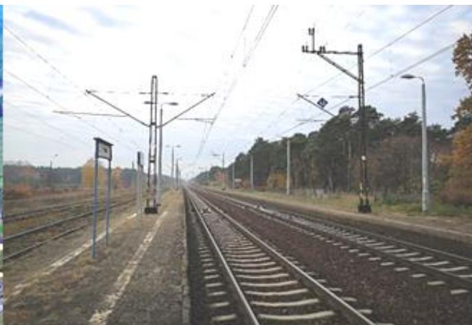
Ryc. 2. Linia kolejowa nr 18 na stacji Cierpice (fot. Kajetan Rożej)
